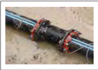
Fig. 23 "Mega-Lug" DIP Spool
