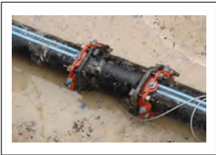
Fig. 23 "Mega-Lug" DIP Spool
